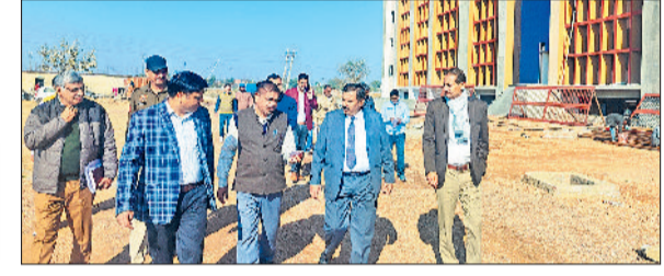
भिवानी। लघु सचिवालय के निर्माणधीन भवन का निरीक्षण करते डीसी डॉ. मुनीश नागपाल। फोटो: हरिभूमि
